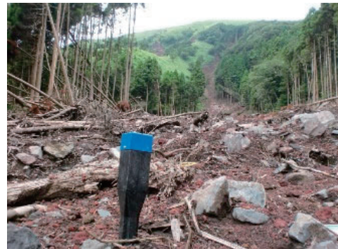
図3 斜面の土砂をIoTセンサーで計測
