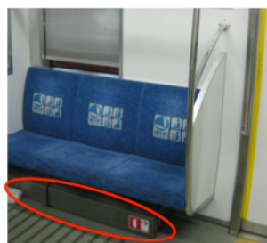
図 4 車内の消火器位置
