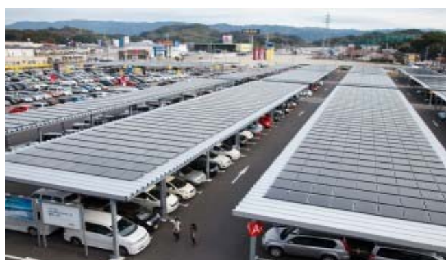
Fig. 6 駐車場におけるPVパネル設置例 イケア福岡新宮店
