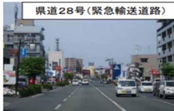
無電柱化により被害なし
